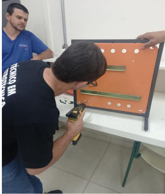
Figura 24 - Montagem dos trilhos na base
