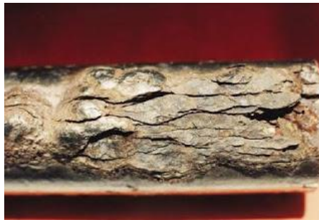
Figura 7 - Corrosão por esfoliação em tubo de aço
