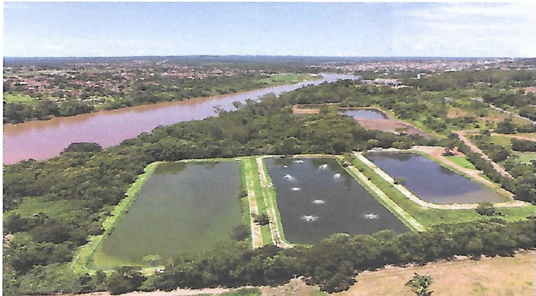
Figura 9 – Estação de Tratamento de Esgoto a Margem do Rio Araguaia, na cidade de Barra dos Garças – MT, com capacidade para tratar 252 L/s de esgoto.
