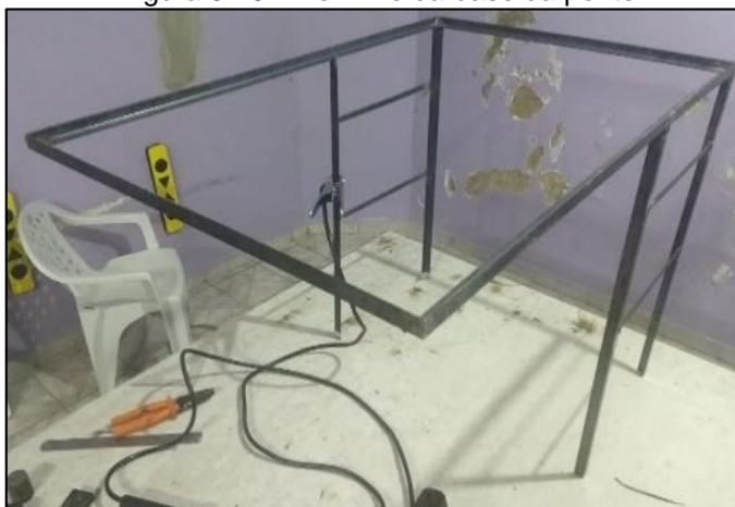
Figura 3.16 – Término da base da ponte
