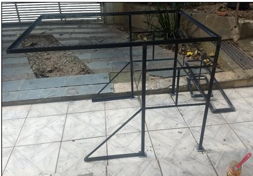
Figura 3.19 – Aplicação do neutralizador de ferrugem
