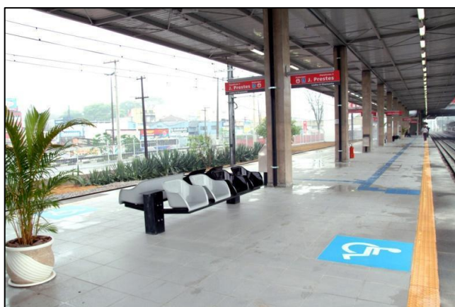
Figura 1.3 – Plataforma da estação Itapevi da CPTM
