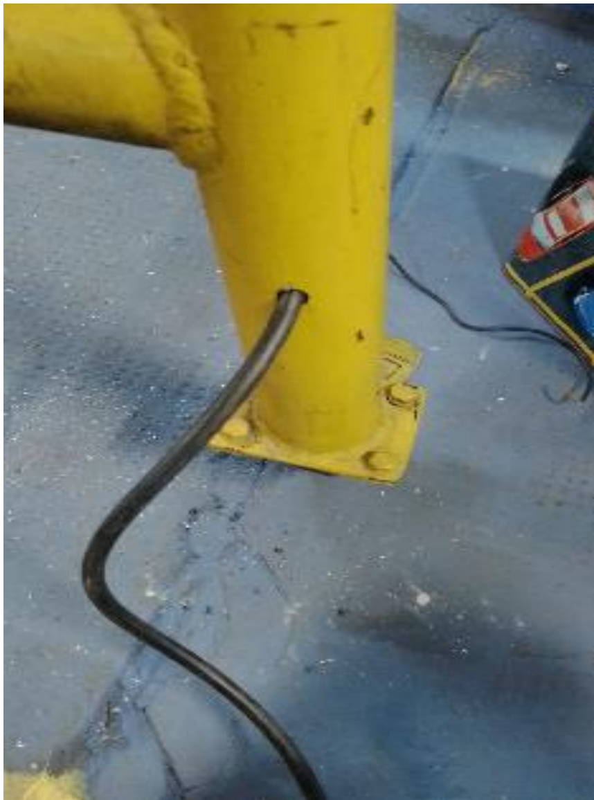
Figura 9 - Passagem do cabo de alimentação da talha
