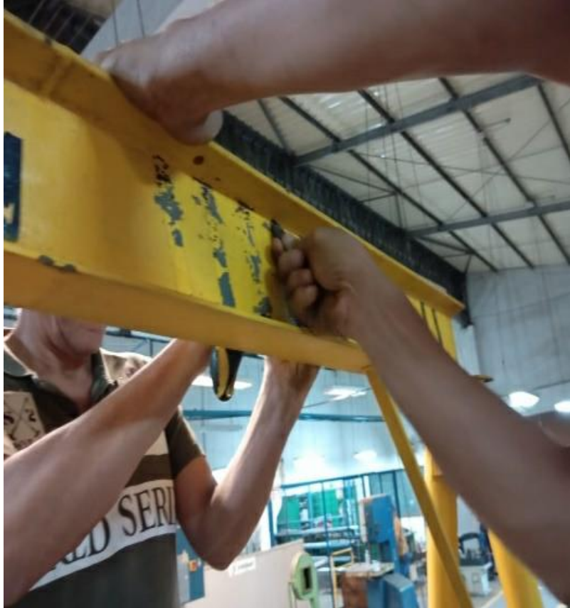
Figura 7 - Raspagem de imperfeições da talha elétrica
