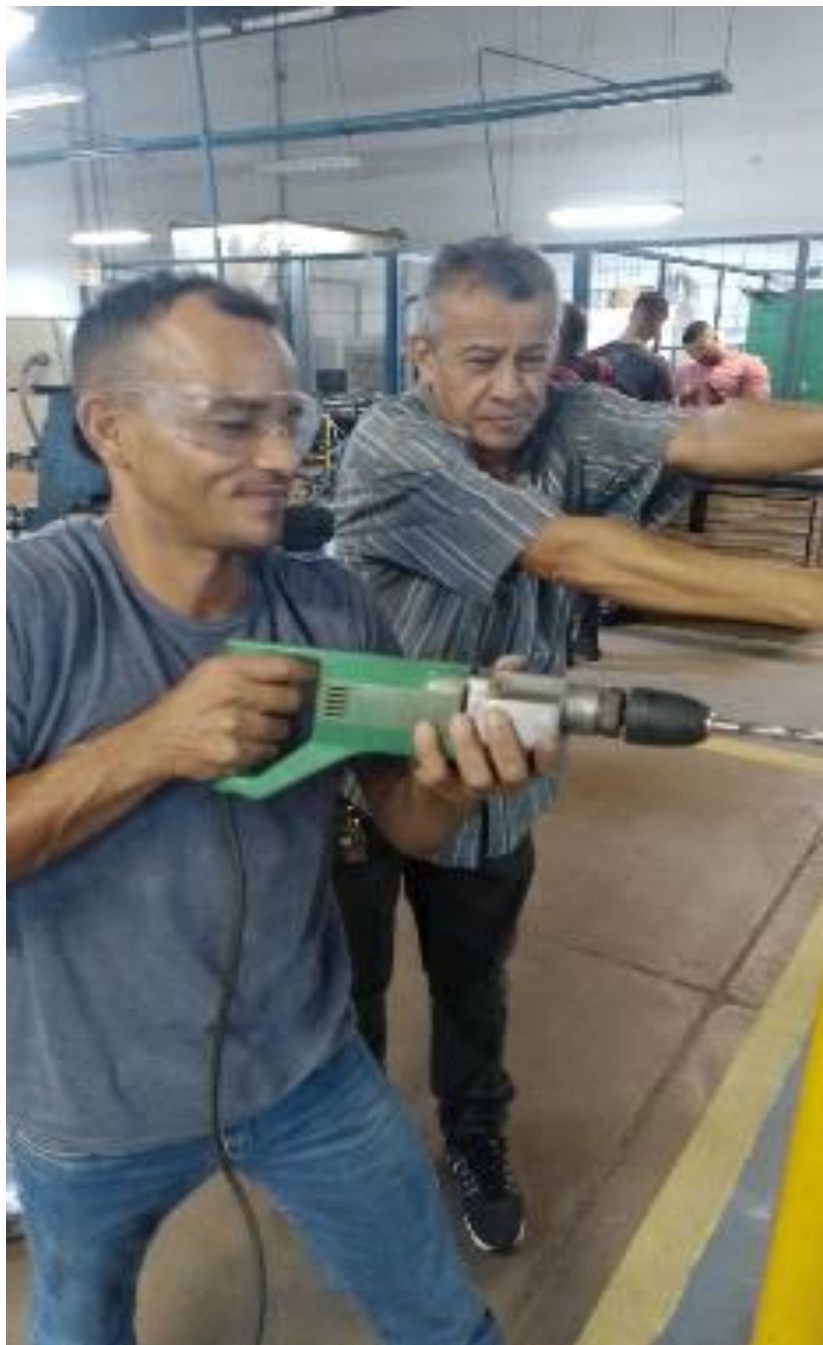
Figura 5: furação da estrutura tubular
