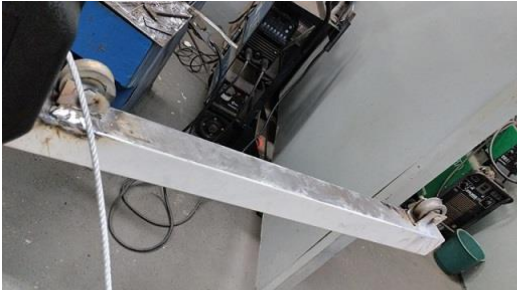
Figura 12: Soldagem das roldanas Fonte: Dispositivo móvel
