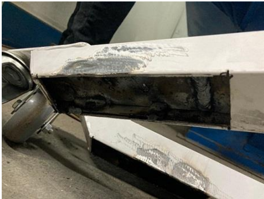
Figura 13: Soldagem dos pesos nos pés guincho Fonte: Dispositivo móvel
