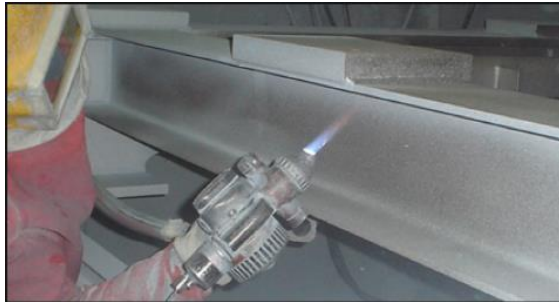
Figura 1 – Aspersão Térmica em Estrutura Metálica Civil
