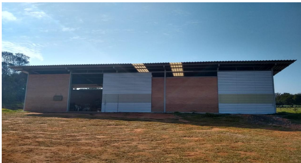
Foto 1: Galpão de armazenagem e separação dos resíduos coletados
