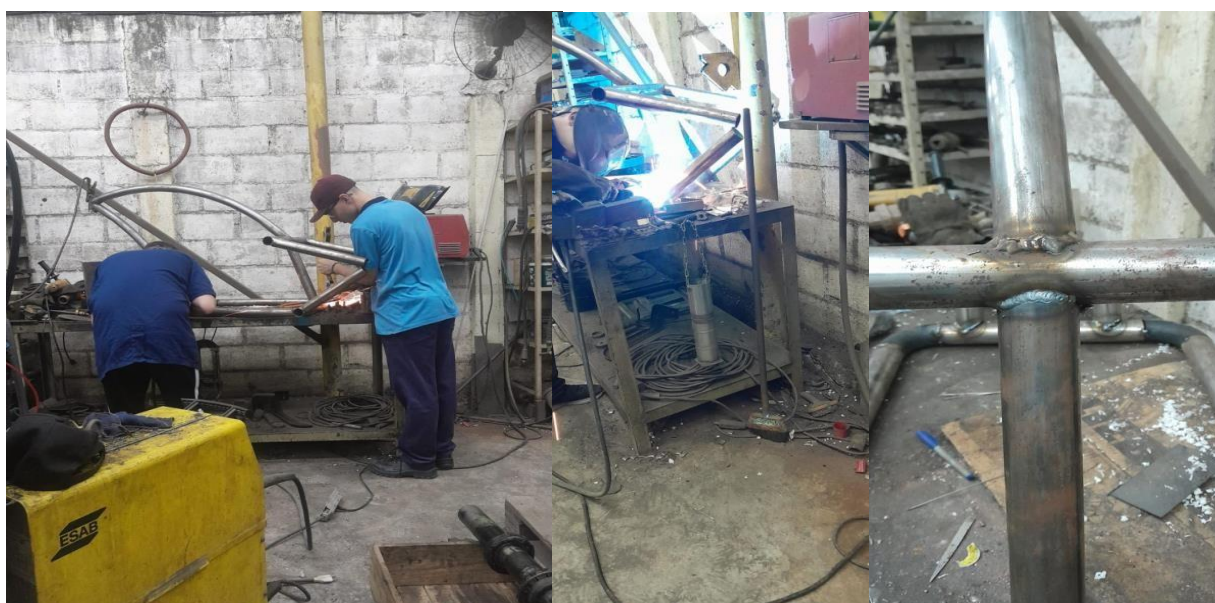
Figura 3 - Solda dos tubos
