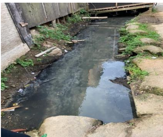
Figura 2 - Esgoto a céu aberto.
