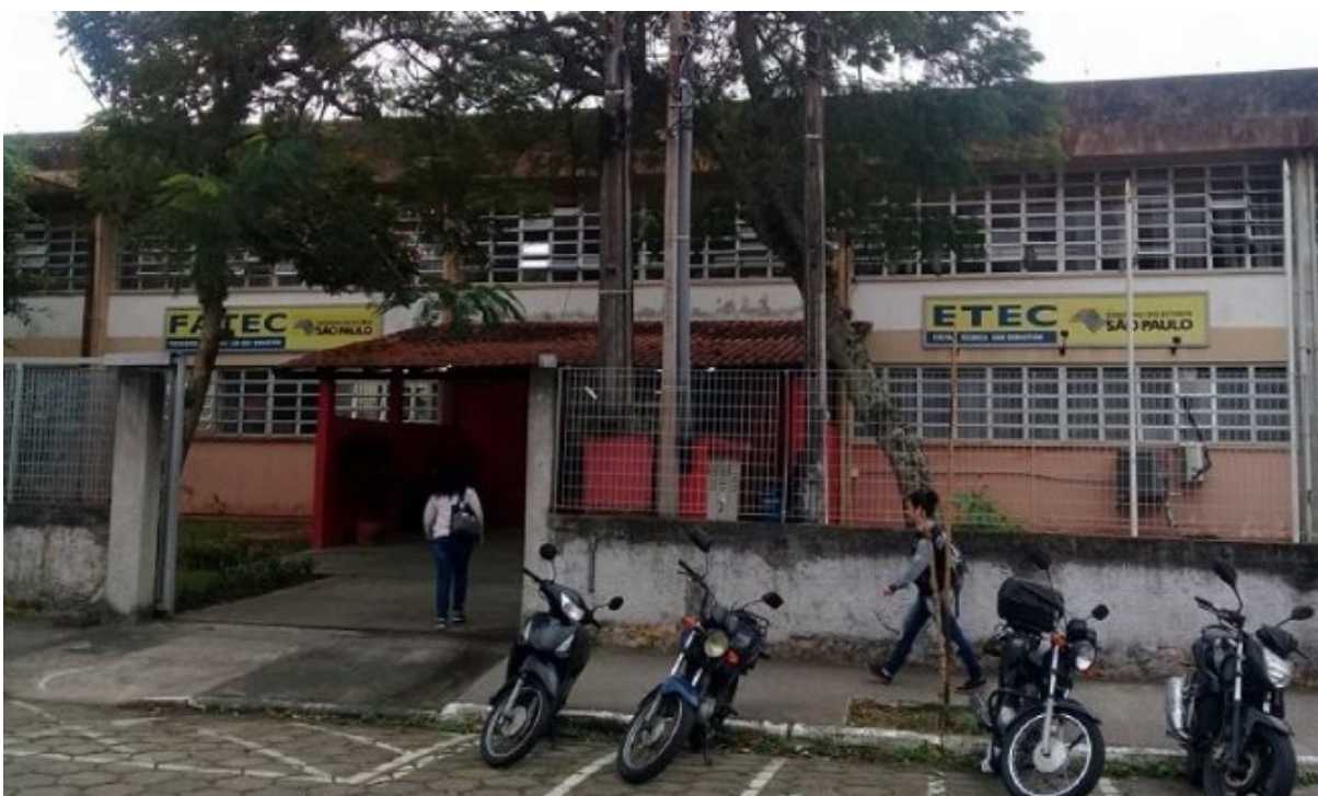
Figura 02 – Portão de entrada da ETEC de São Sebastião
