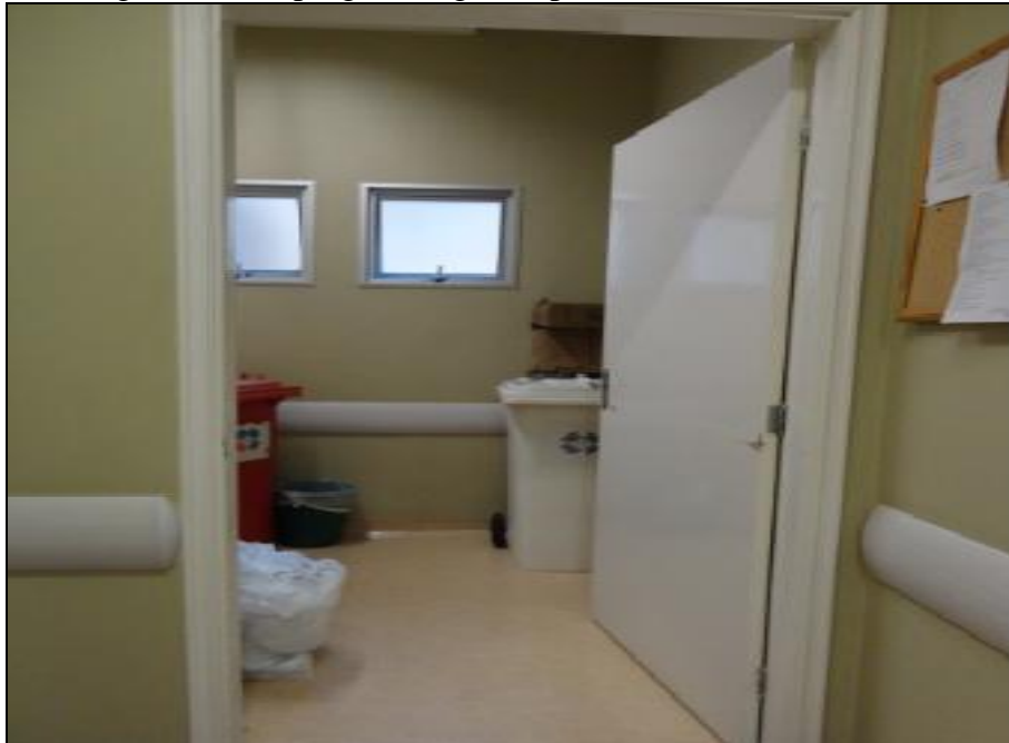
Figura 13 - Expurgo (abrigo temporário) de um dos andares
