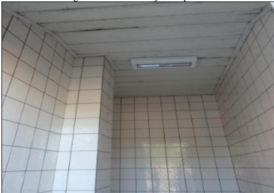
Figura 23 - Teto e azulejos nas paredes
