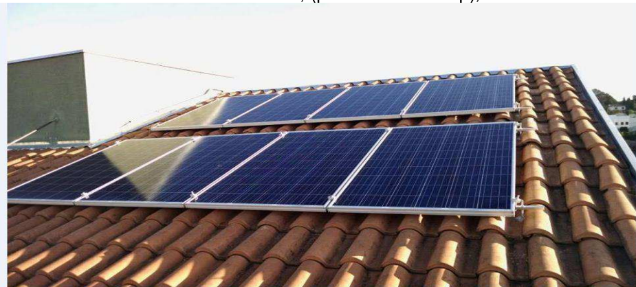
Sistema Fotovoltaico Residencial, (potência de 3 kWp), São Carlos-SP.
