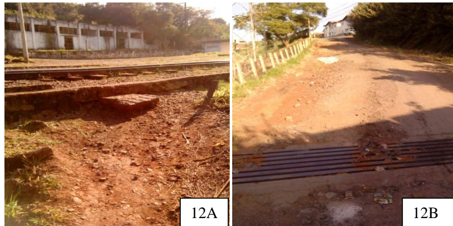
Figura 12A) - Acessibilidade Ferrovia; 12B) - Rampa de acesso a outros Bairros.
