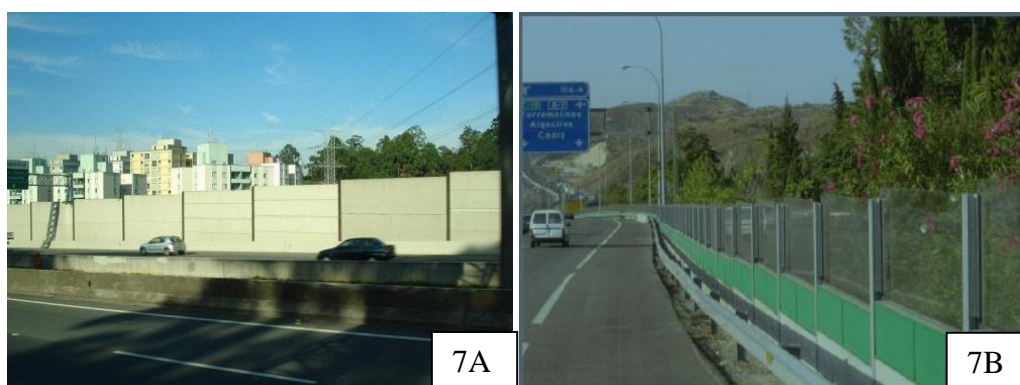
Figura 7A e 7B – Barreiras Rodoviárias
