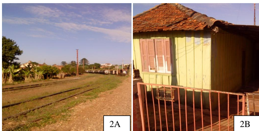
Figura 2A) - Vista da via férrea com as casas afetadas; 2B) - Tomada da parte frontal da residencia afetada pelos impactos do modal ferroviário.
