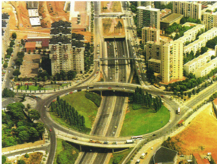
Figura 11 – Rotatória em Desnível
