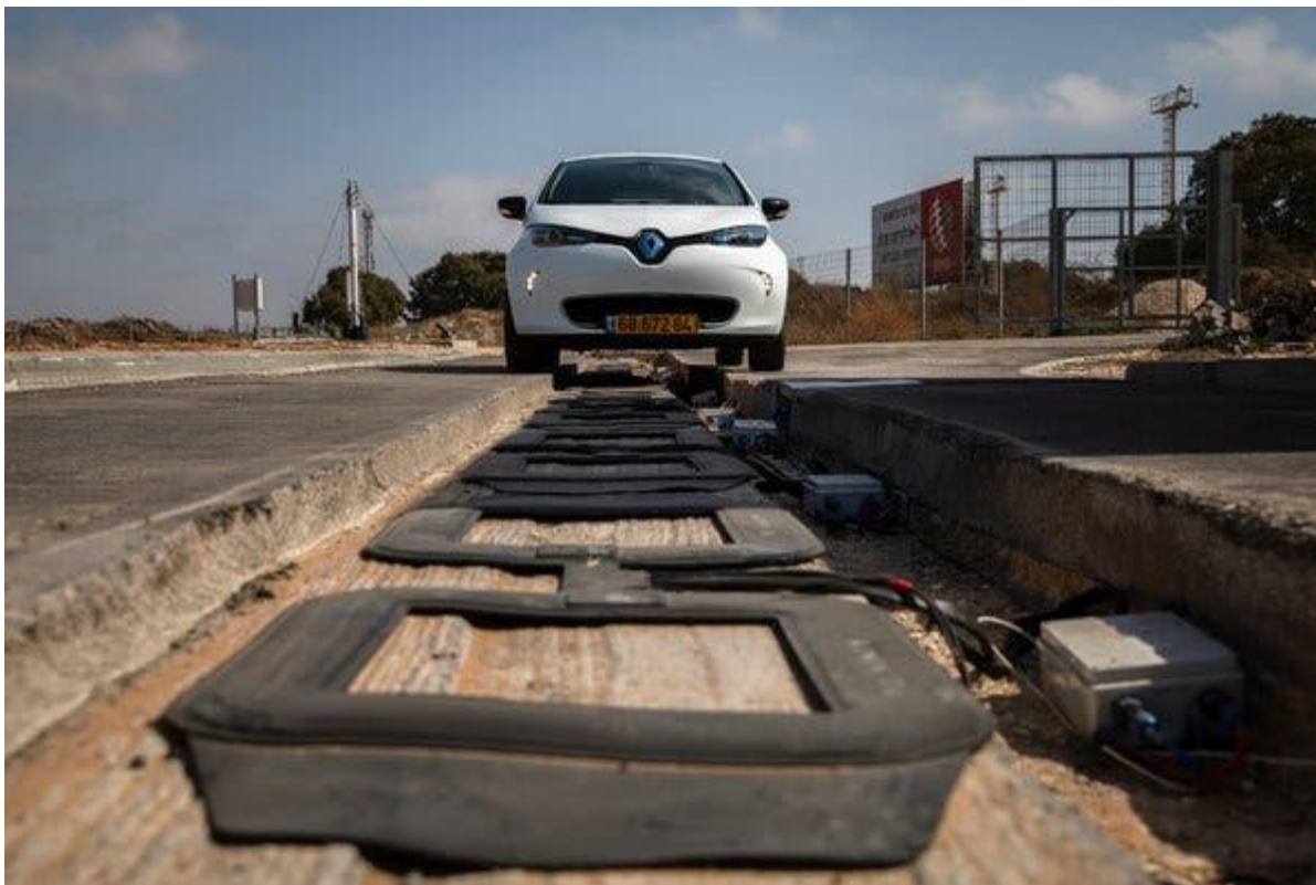
Figura 64: Renault Zoe e pontos de recarga sem fio em processo de instalação
