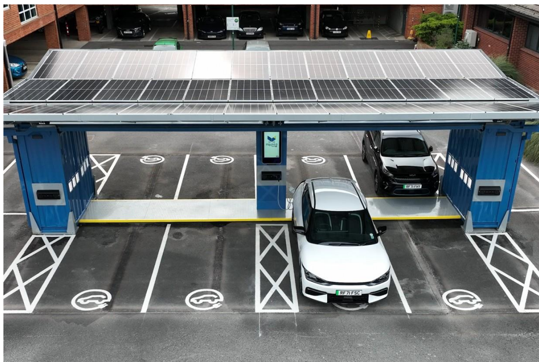
Figura 53: Estacionamento com placas fotovoltaicas retráteis.
