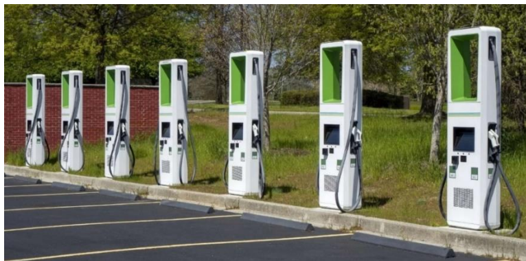
Figura 56: Carregadores para vagas de estacionamento perpendiculares, com canteiro paralelo.
