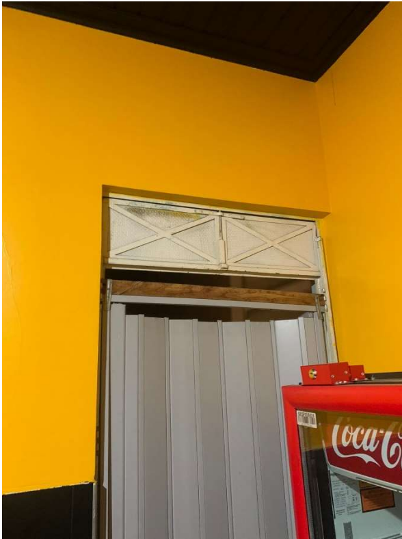
Porta que dá acesso a área de armazenagem do gás.
