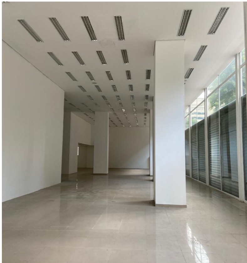
Figura 17 FOTOGRAFIA DO INTERIOR DO IMÓVEL
