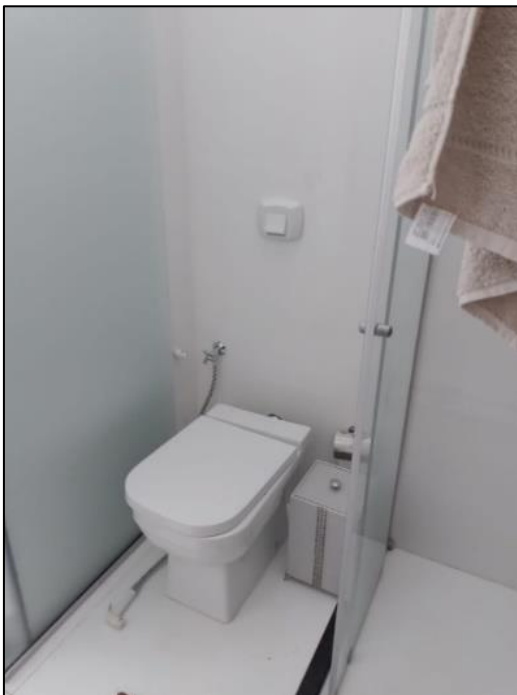
Figura 49 - Interior do banheiro da suíte
