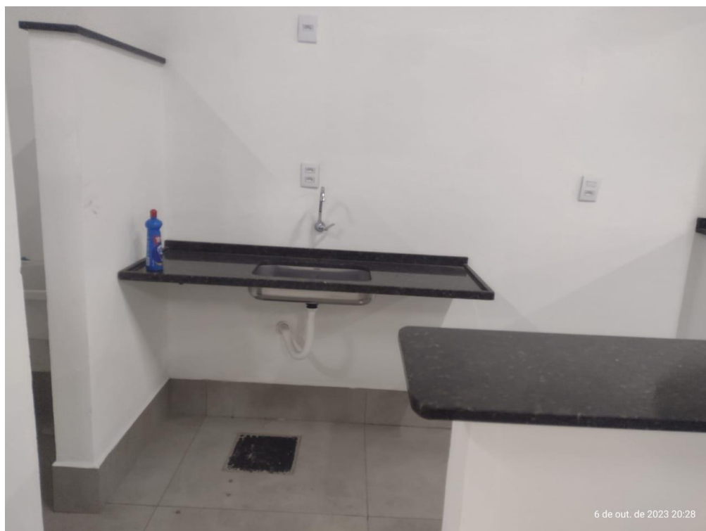
Figura 22: Vista interna da cozinha.
