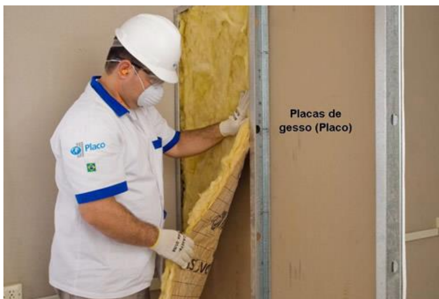
Figura 19 - Colocação do isolamento acústico.
