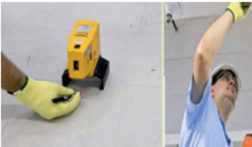
Figura 13 - Marcação das paredes.
