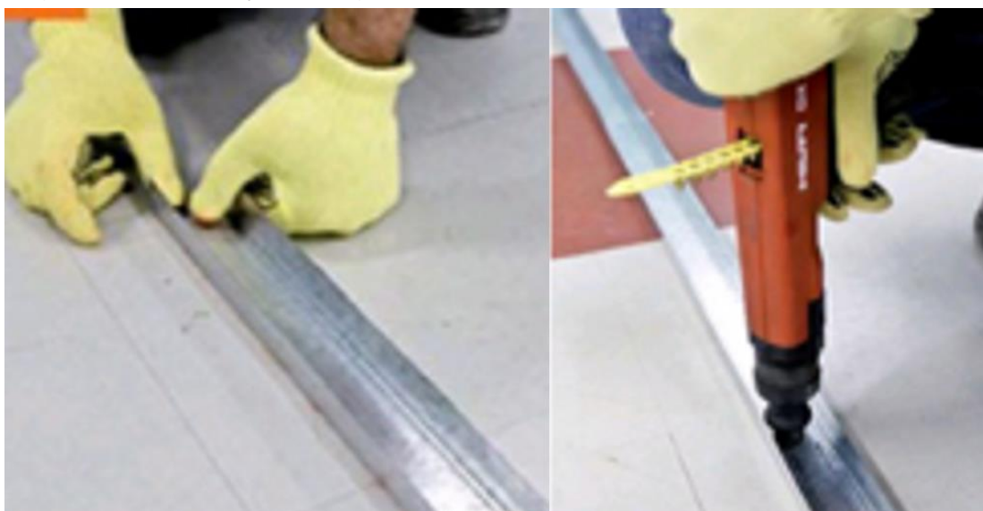
Figura 14 - Instalação das guias de piso, parede e teto.
