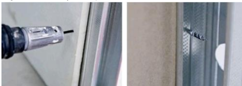
Figura 16 - Instalação dos placas.
