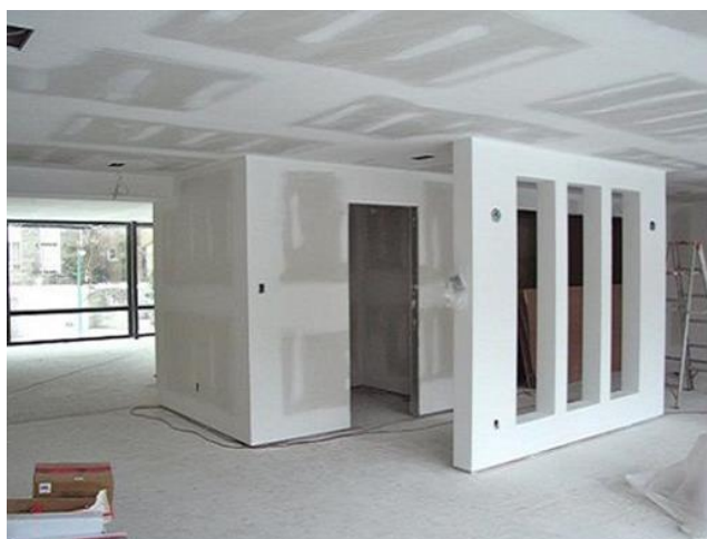
Figura 21 - Rejunte de chapas e cantos.
