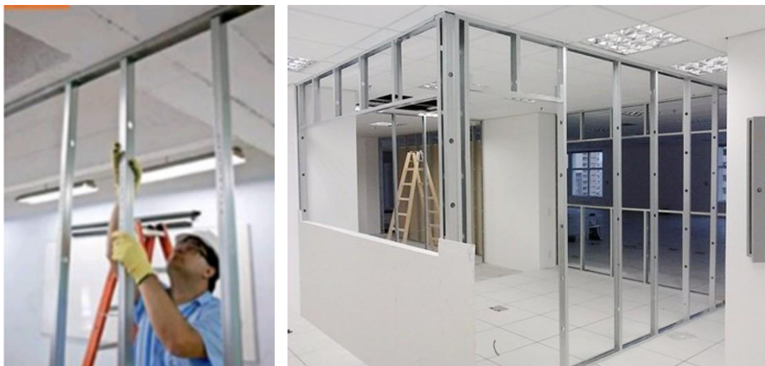
Figura 15 - Instalação dos montantes.
