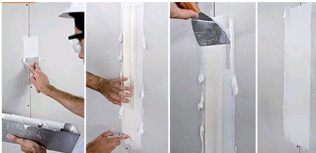
Figura 20 - Rejunte de chapas e cantos.
