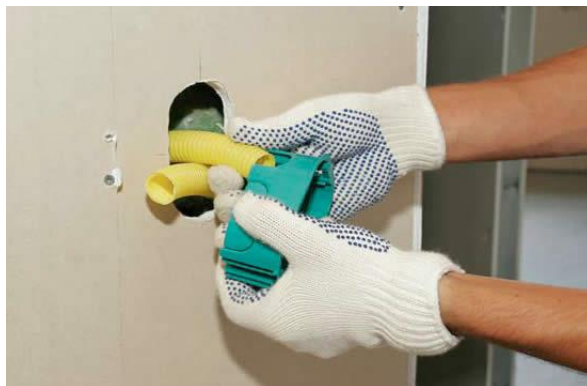
Figura 17 - Passagem de Instalações Hidráulicas e Elétricas.
