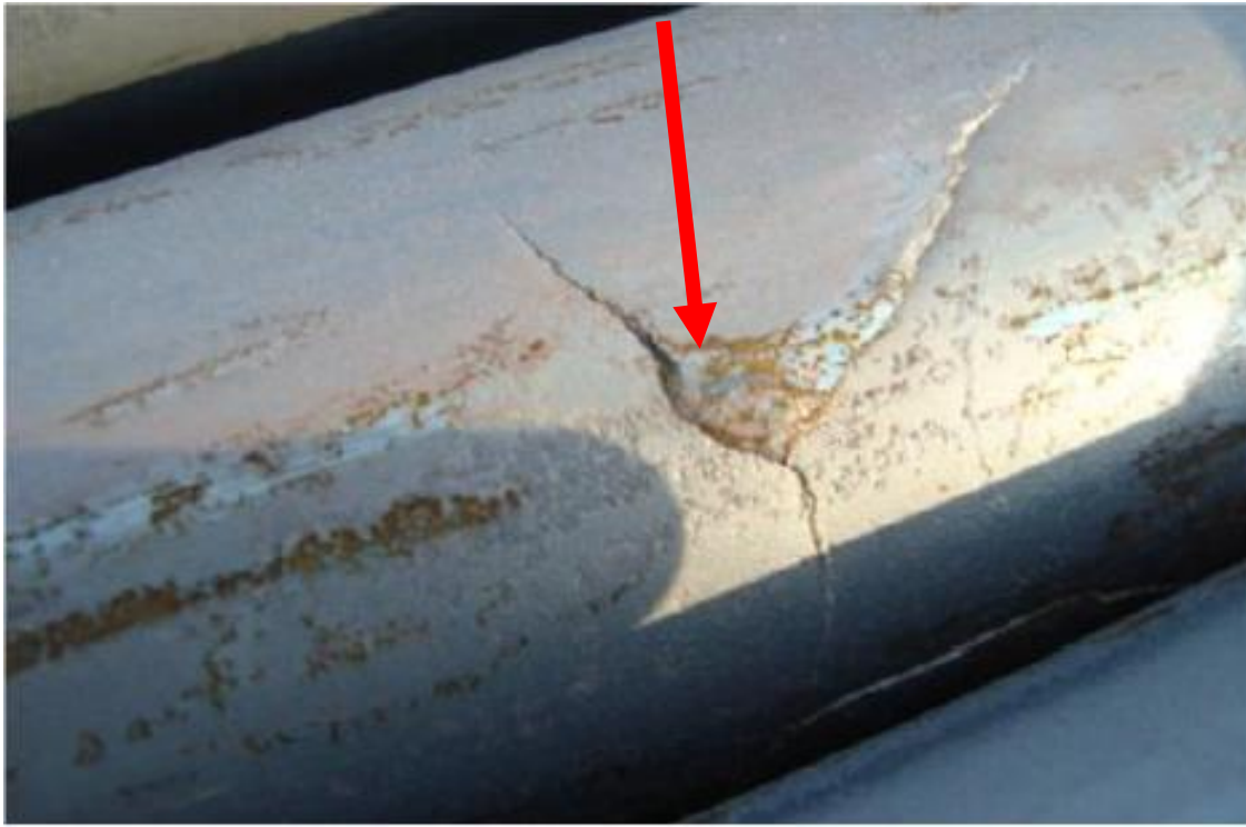
Figura 18 - Marcas de laminação.
