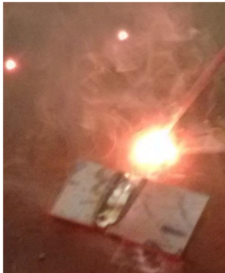
Figura 10. Chapa de Inox sendo Soldada
