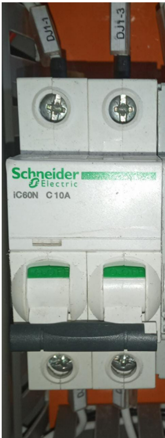
Figura 10 - Disjuntor
