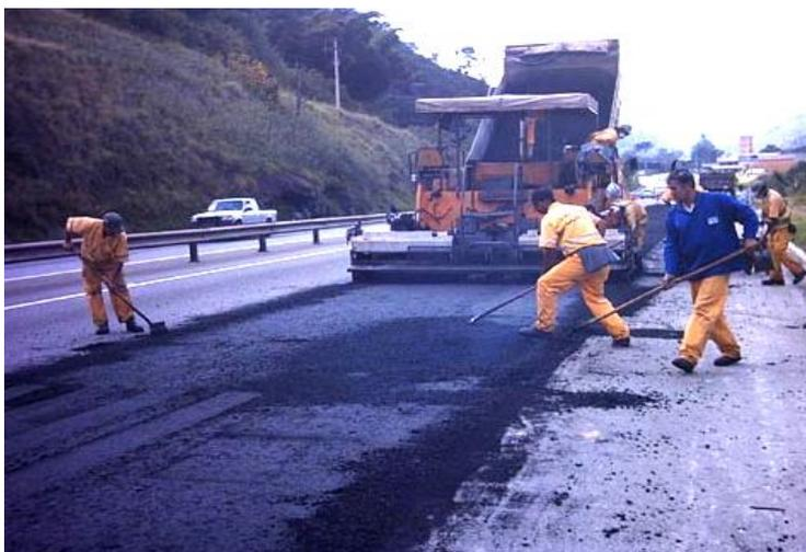
Figura 17. Aplicação da massa asfáltica contendo borracha de pneumáticos inservíveis.
