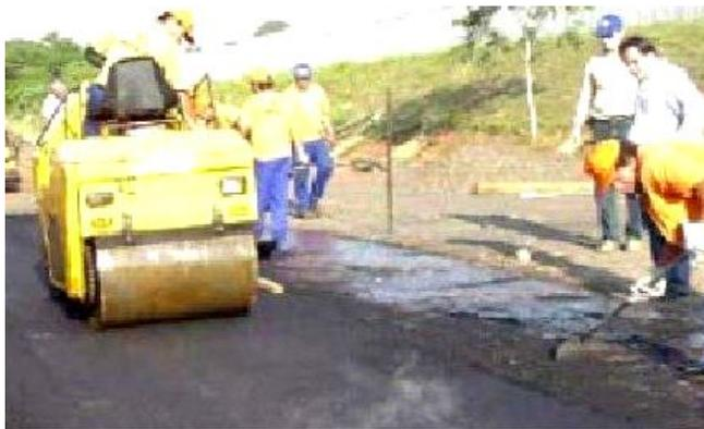
Figura 18. Processo de compactação inicial do pavimento de borracha com rolo vibratório.
