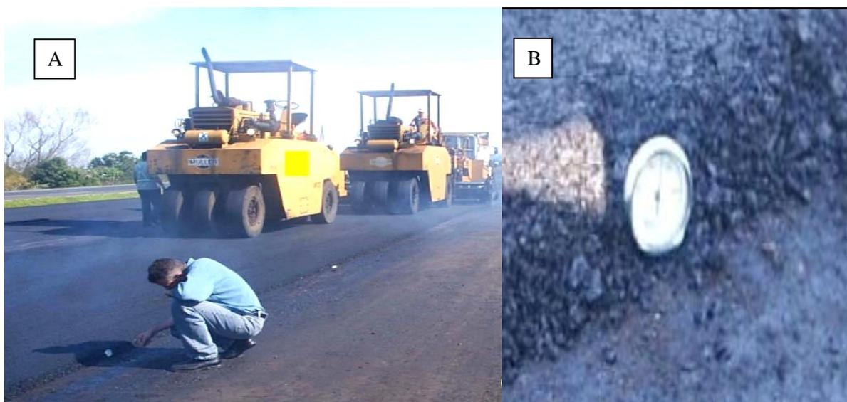
Figura 21. A) Técnico realizando a medição da temperatura de aplicação da massa asfáltica contendo borracha de pneumáticos inservíveis com o auxílio de um termômetro de mercúrio; B) Detalhe do termômetro de mercúrio realizando a medição da massa asfáltica.
