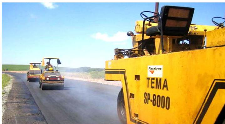
Figura 19. Processo de compactação final do pavimento de borracha com rolo vibratório.
