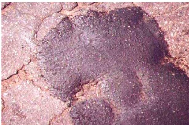
Figura 14. Situação física do trecho experimental desenvolvido por Charles Mac Donald após um ano de aplicação (1964).
