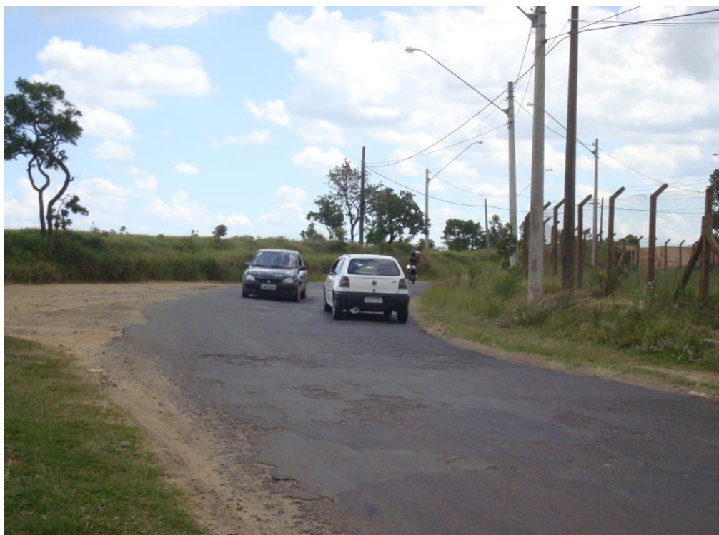
Figura 11. Situação de risco na acesso do Hospital e da Fatec.
