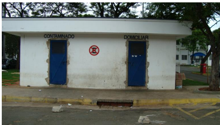
Figura 14. Abrigo externo de resíduos comuns e infectantes.
