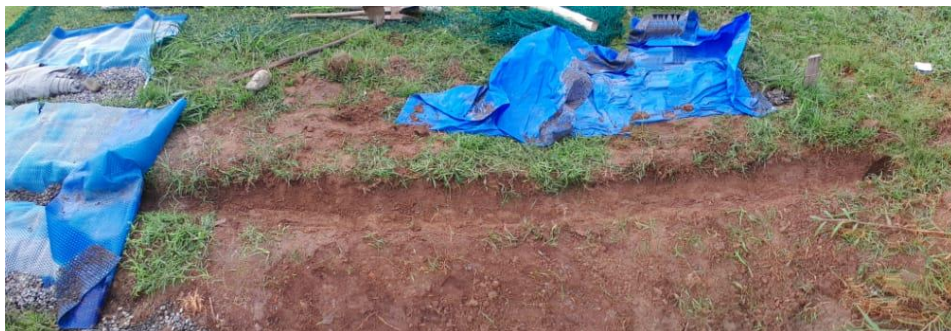
Imagem 3 – Abertura do espaço para o balde e o cano
