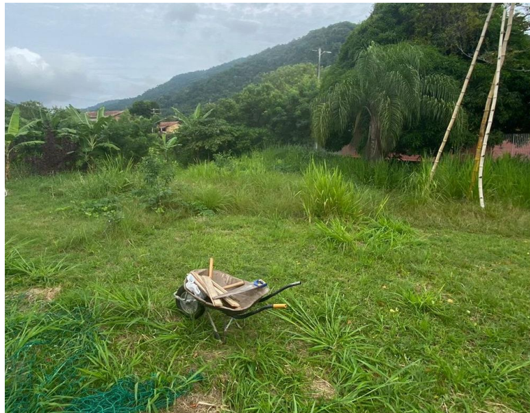
Imagem 1 – Determinação de área para construção da composteira
