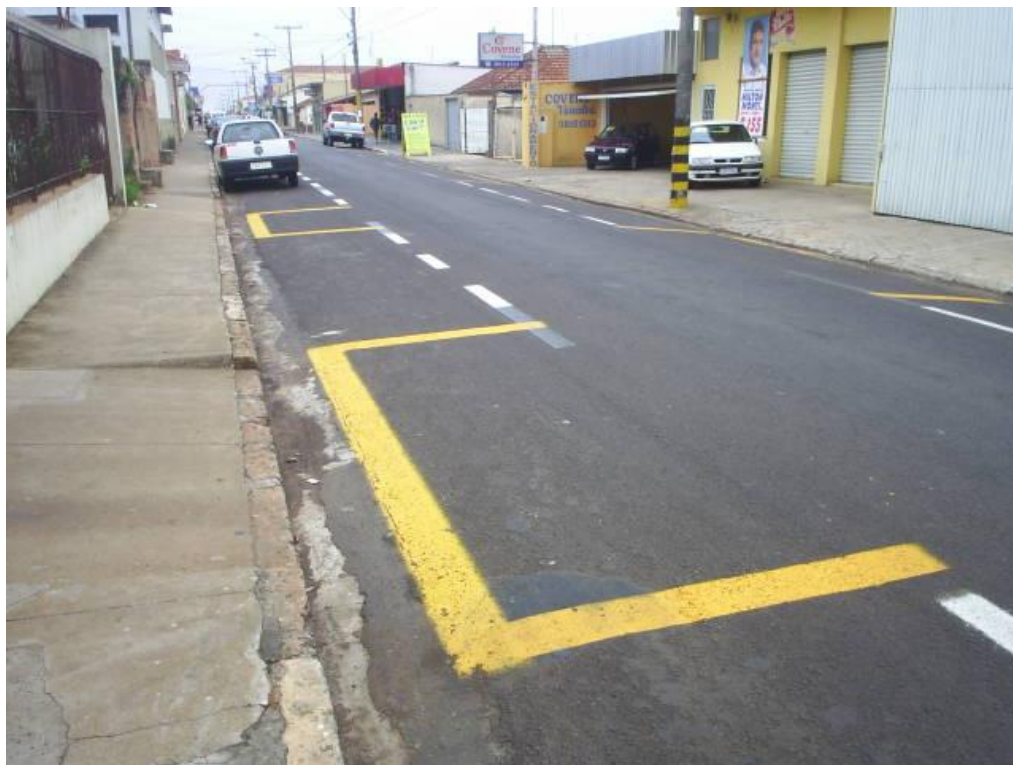
Figura 3 – Foto 2: Pintura de guias rebaixas e área de estacionamento
