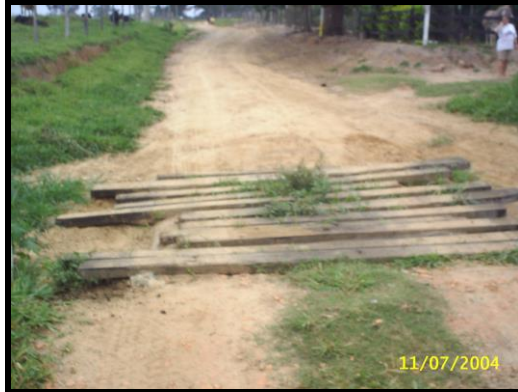
Figura 3– Mata burro quebrado Estrada de terra partindo do Km 209 da Rod. Mal. Rondon. Foto produzida pelo autor (2005)
