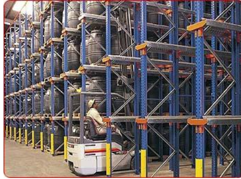
FIGURA 12 - Estruturas porta-paletes com trânsito interno
