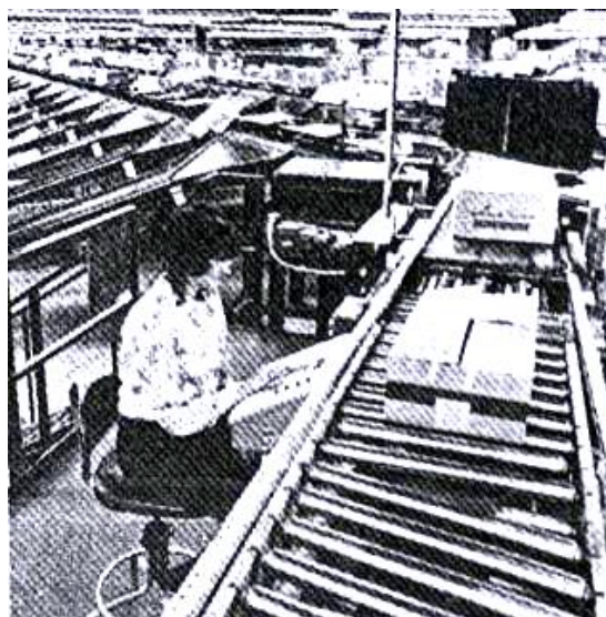
Figura 26 – Transportador de roletes
