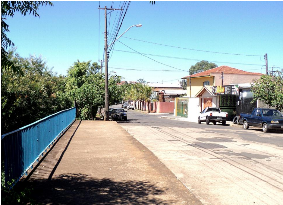
Figura 11 – Ponte localizada próxima ao antigo Matadouro Municipal, na Avenida Paula Vieira.
