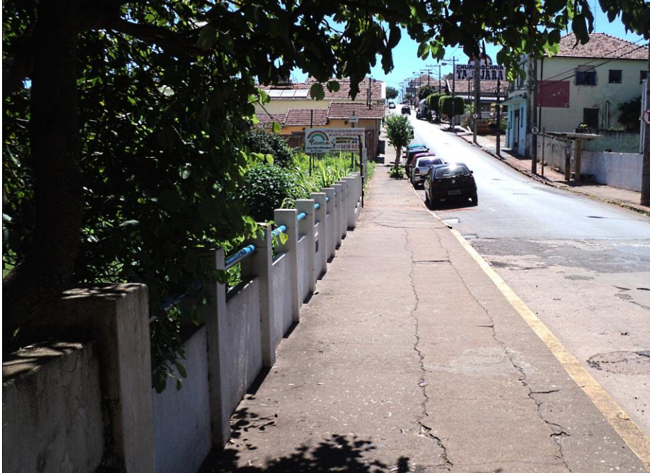
Figura 9 – Ponte que dá acesso ao Bairro Alto através da Rua Siqueira Campos.
