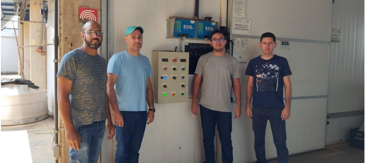
Figura 12: Entrega técnica do sistema de climatização à empresa Depósito Ito Comércio de Frutas e Legumes
