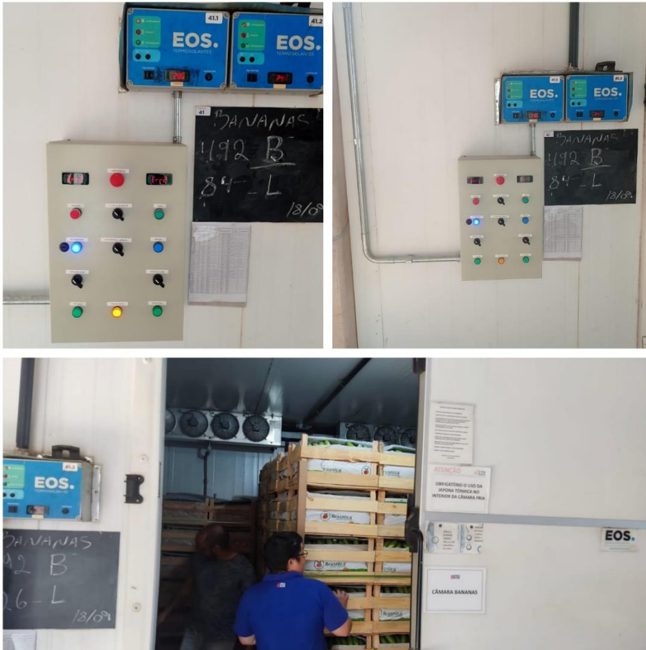
Figura 9: Primeiro teste com o sistema de climatização com 12t de bananas nanicas.
