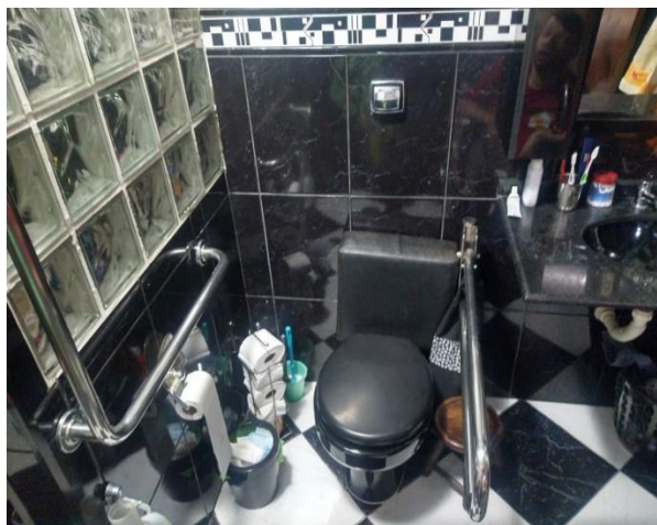
Figura 28- Vista do vaso sanitário com barras de apoio
