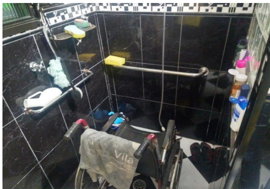
Figura 27- Vista da aérea do chuveiro com barras de apoio para banho
