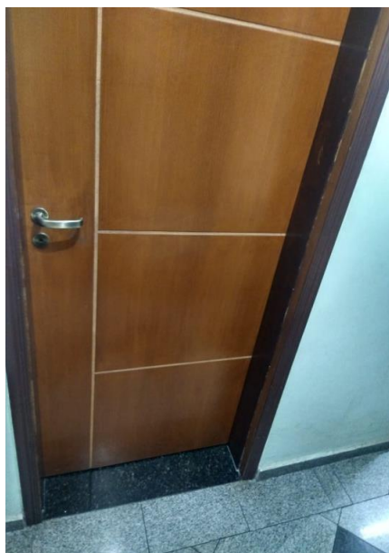
Figura 32- Vista da porta
