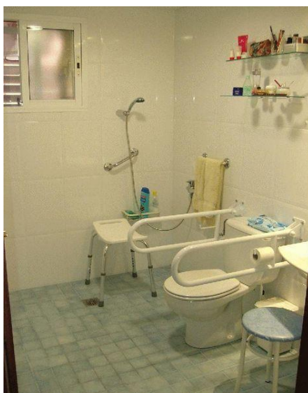
Figura 34- Exemplo de banheiro acessível
