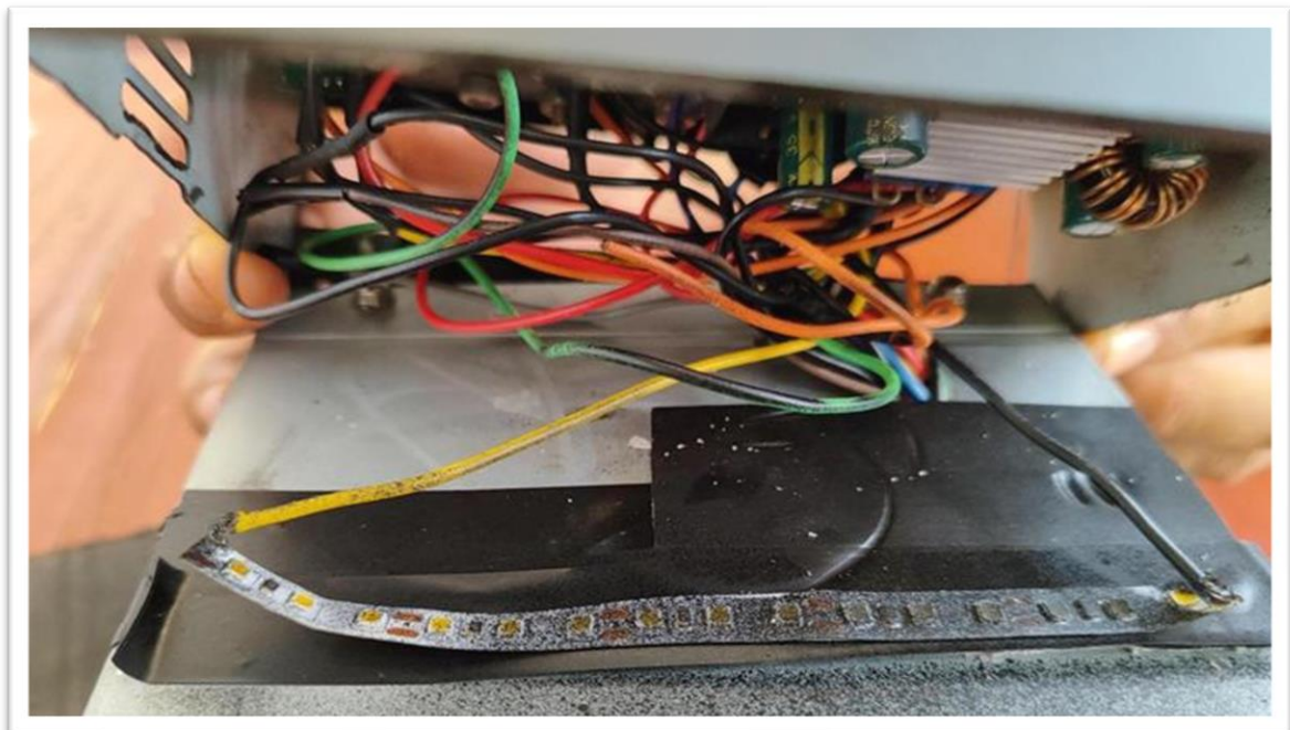
Figura 16 - Cabos Soldados e Isolados com Termo Retrátil
