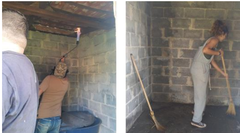
Figura 4 - Limpeza e higienização do local
