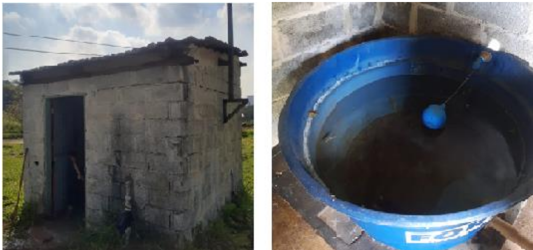
Figura 3 - Exterior e interior da casa
