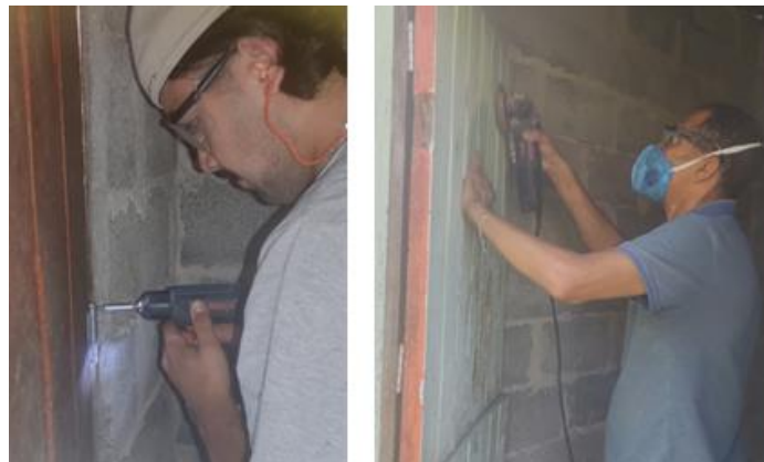
Figura 5 - Reparos das dobradiças e raspagem da tinta da porta
