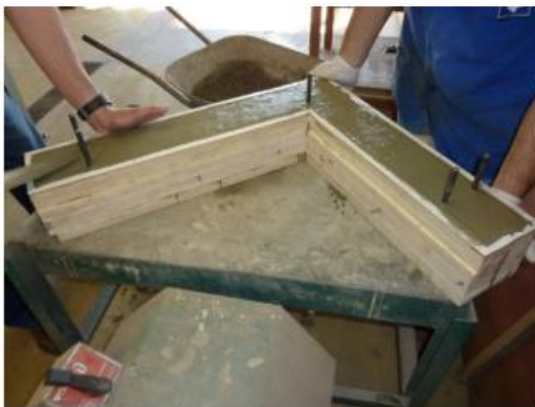
Figuras 8 e 9 – Moldagem de peça de ligação “L”.
