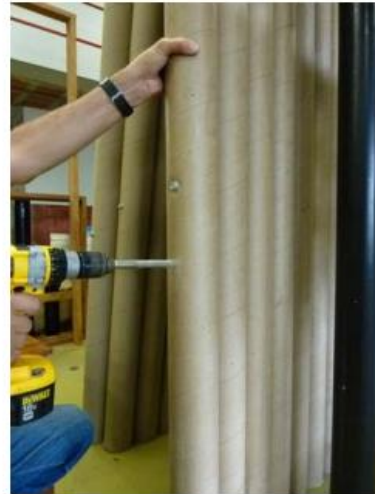
Figuras 3 e 4– Painéis de vedação prontos e furação nas laterais.
