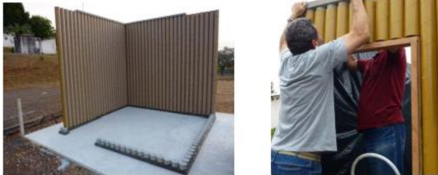
Figuras 15 e 16 – Fixação dos painéis de vedação e das peças de ligação superiores.
