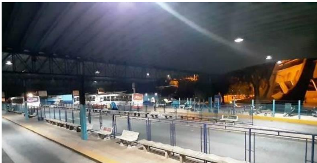
Figura 03: Terminal Urbano – Região Central.
