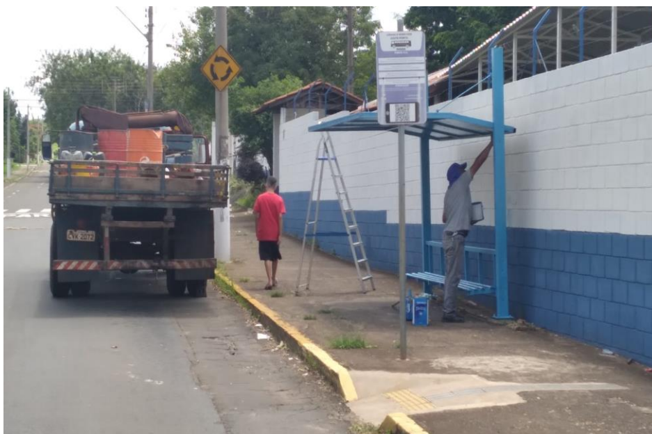
Figura 07: Av. Castelo Branco, manutenção e pintura.
