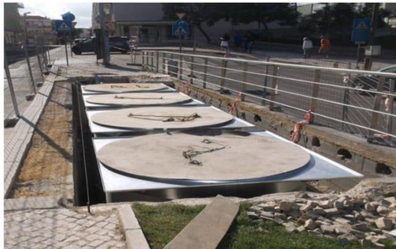
Colocação do Contêiner e contentor. Fonte: (MBE- Sotkon,2008)
