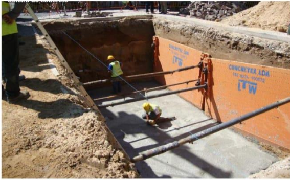
Soleira de concreto e escoamento lateral. Fonte: (MBE-Sotkon,2008)
