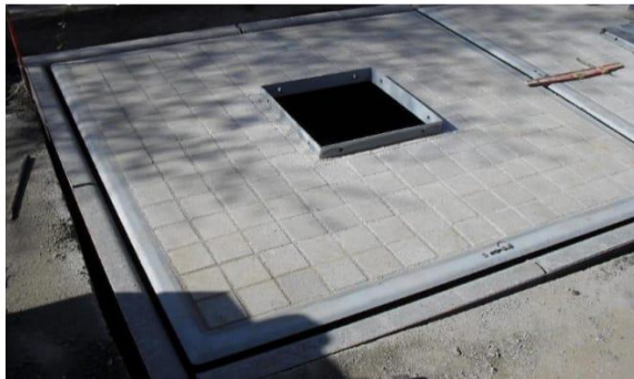
Colocação do Pavimento. Fonte: (MBE- Sotkon,2008)
