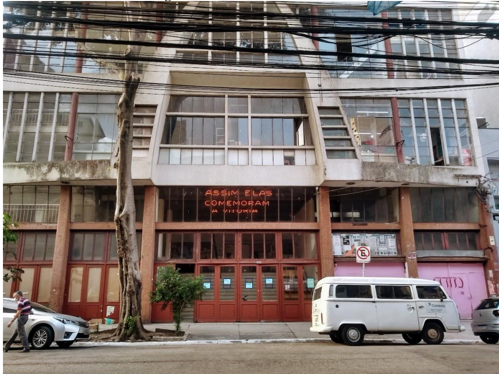
Figura 1 - Fachada da Casa do Povo.
