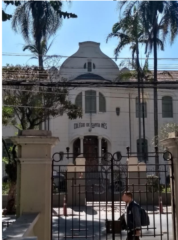
Figura 18 - Fachada do Colégio Santa Inês.
