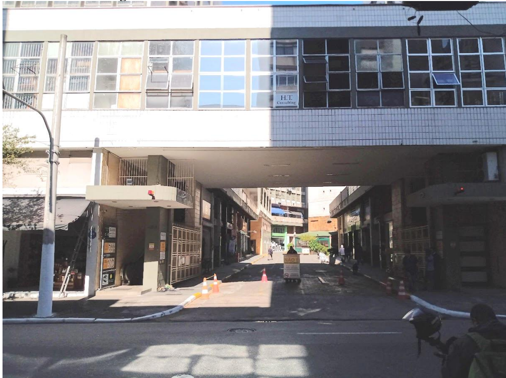
Figura 21 - Entrada do Centro Comercial Bom Retiro.
