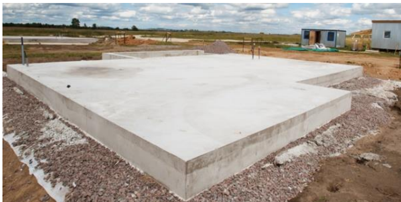
Figura 13 - Fundação tipo Radier
