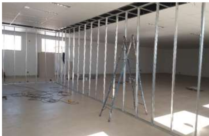
Figura 18 - Instalação de Montantes (fonte:O Autor,2021)
