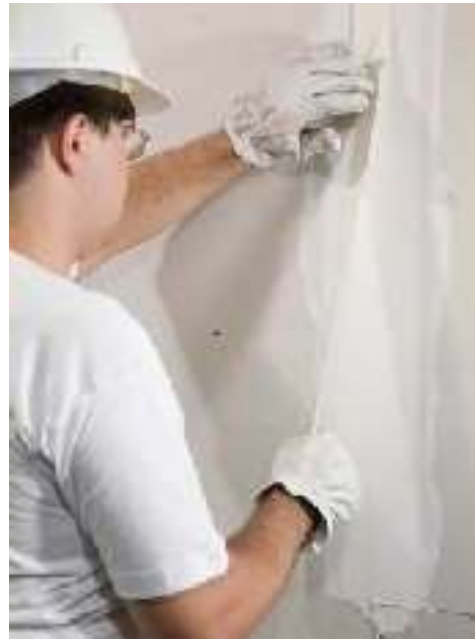
Figura 7- Tratamento das juntas
