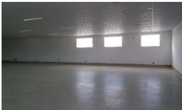
Figura 15 - Área livre sem Drywall (fonte:O Autor,2021)
