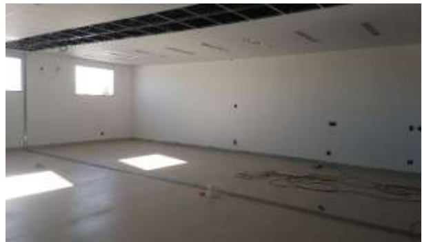
Figura 16 - Nivelamento dos perfis e montantes (fonte:O Autor,2021)
