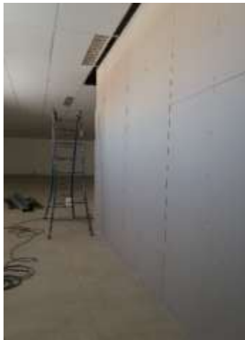
Figura 19- Fixação das Placas (fonte:O Autor,2021)
