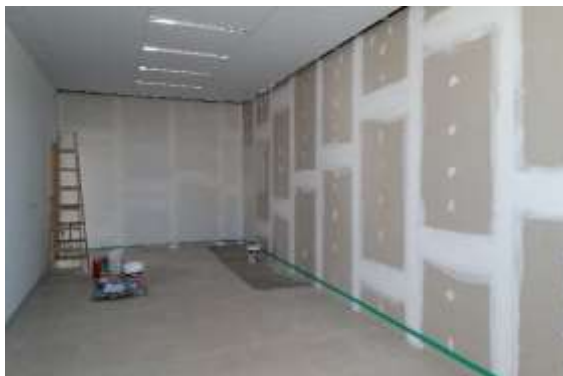
Figura 21 / 22- Aplicação de massa Corrida Pva sob o Gesso acartonado (fonte:O Autor,2021)
