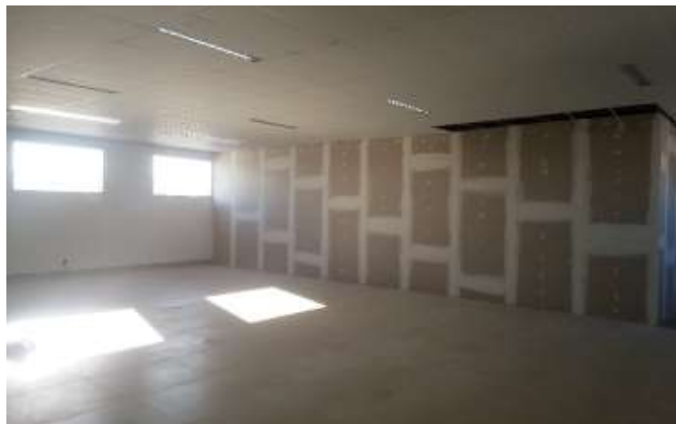
Figura 20 – Tratamento de Juntas (fonte:O Autor,2021)
