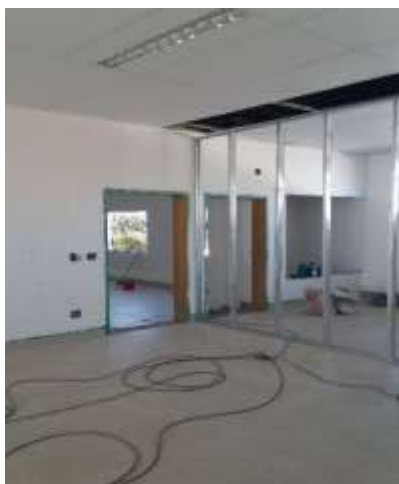
Figura 17- Reproveitamento da Alvenaria (fonte:O Autor,2021)
