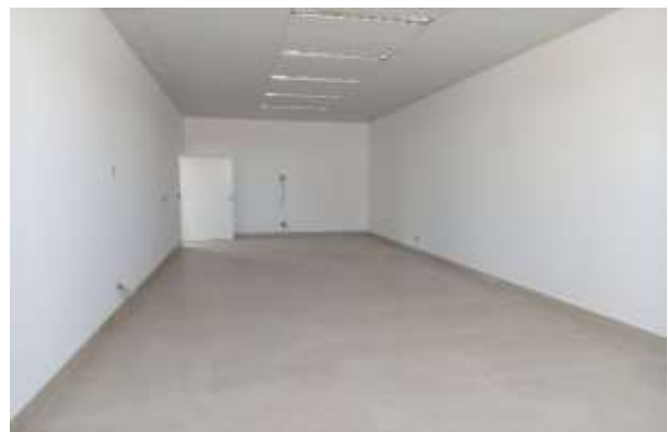
Figura 25/ 26 – Finalização da pintura e limpeza pós obra da sala em drywall (fonte:O Autor,2021)
