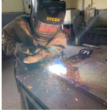
Imagem 14: Solda da estrutura
