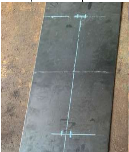
Imagem 12: Marcação na base em que foi soldada a estrutura
