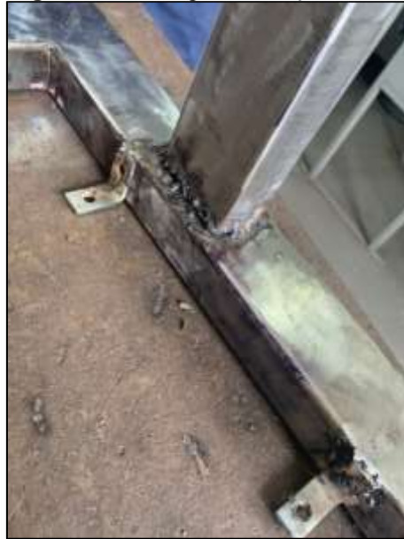
Imagem 23: Soldagem do suporte em “L”
