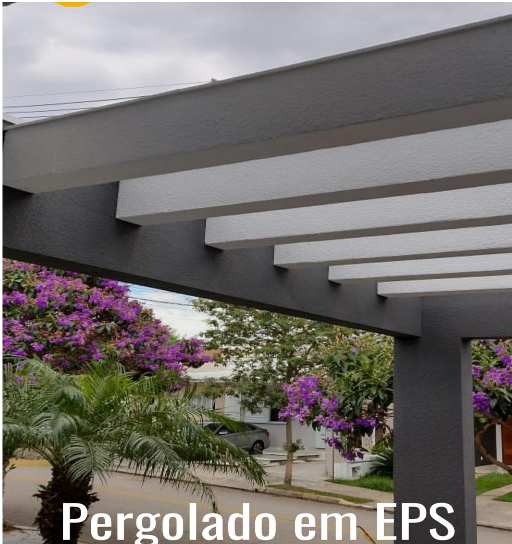
Foto 09 – Pergolado em EPS finalizado
