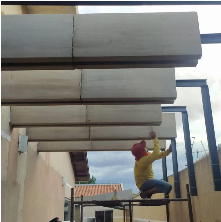
Foto 07 – Instalação de pergolado em EPS com estrutura interna
