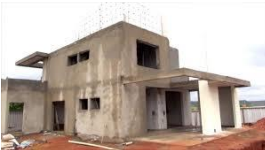
Foto 01 – Construção em EPS (poliestireno expandido)
