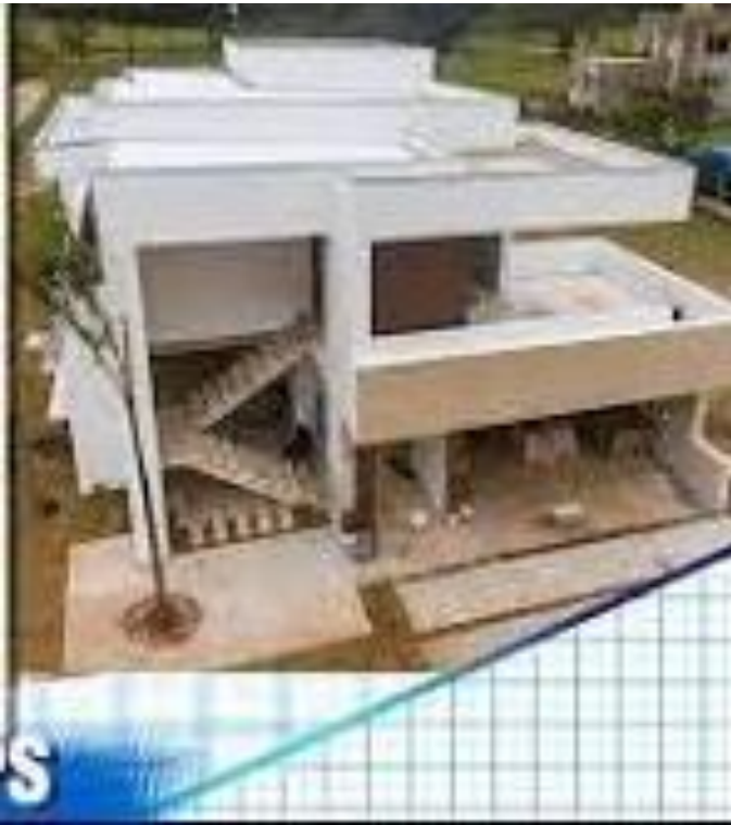
Foto 04 – Laje em balanço em EPS
