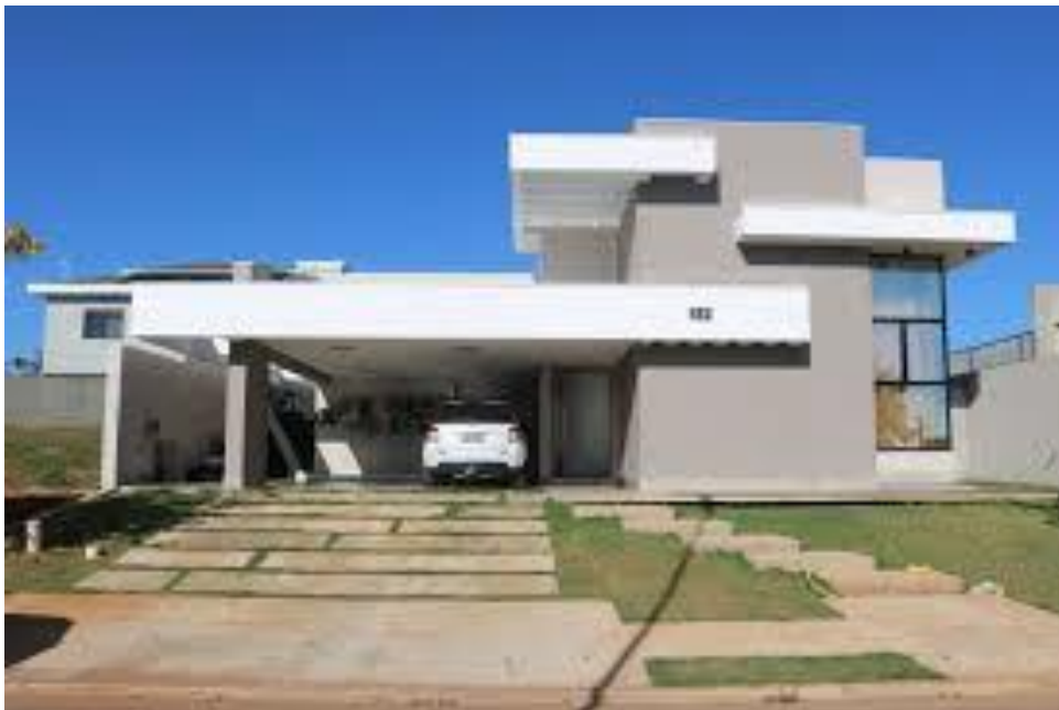
Foto 03 – Laje em balanço em EPS
