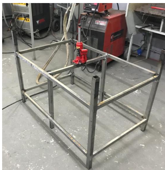
Imagem 14 – Soldagem do macaco hidráulico
