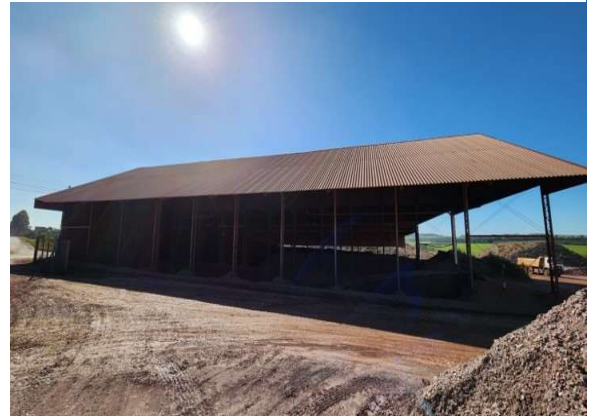
Figura 9 – ARMAZÉM DE ARGILA
