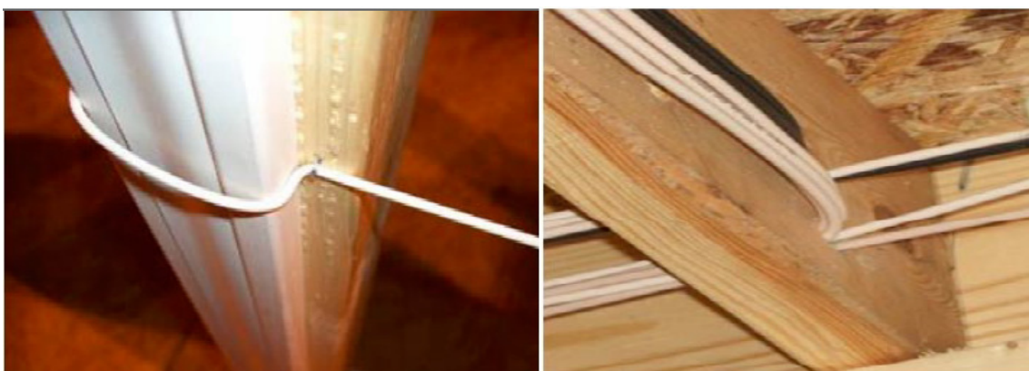
Figura 9 – Curvaturas possíveis com cabo Drop reforçado de 4,9 mm
